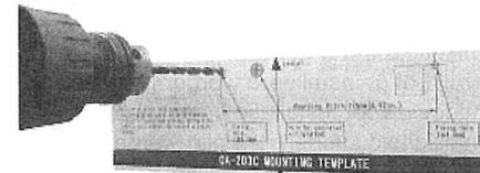
2. Eseguite due fori di montaggio (ø 3,4mm / 1/8").
